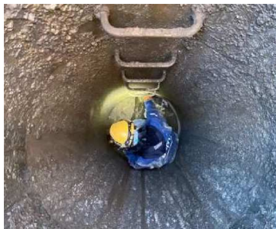
マンホール目視点検の様子
