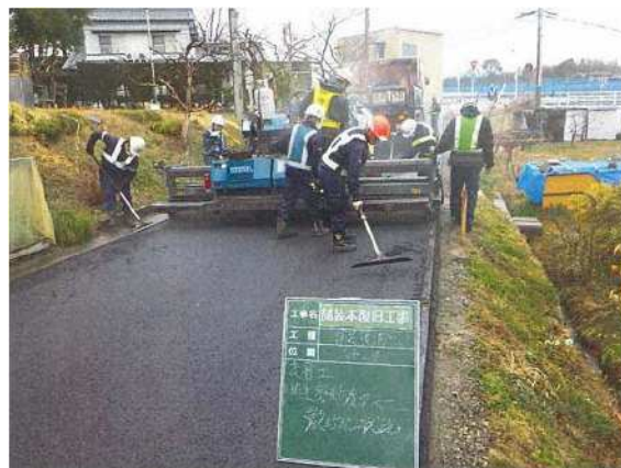
舗装復旧工事の様子
